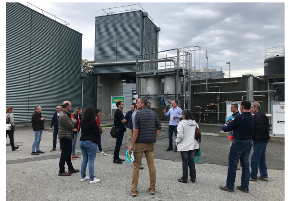
visite de la station d'épuration d'Arenthon
